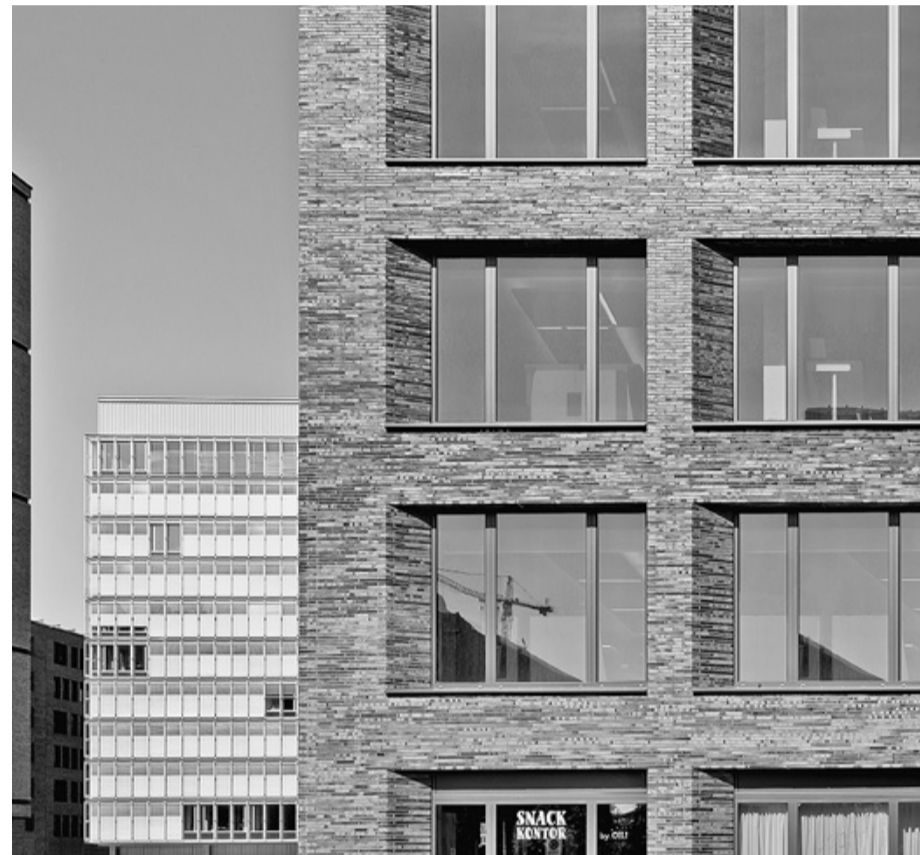
Die handwerklich, in Sonderformaten präzise ausgeführten angeschrägten Fensterlaibungen, ermöglichen einen erhöhten Tageslichteinfall und sorgen so für qualitätsvolle Räume. FOTOS: ANKE MÜLLERKLEIN
