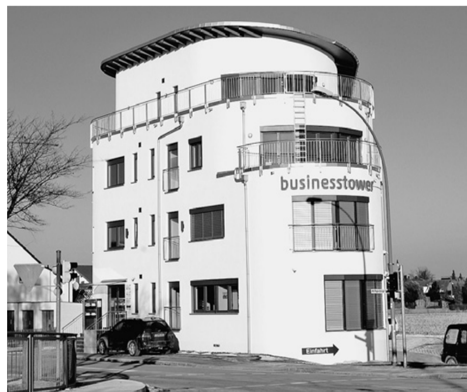
Mit dem Businesstower in Landshut treten die Investoren den Beweis an, dass sich Qualität auch im Gewerbebau rechnet. Trotz großer Deckenaufasten und Fensterformate überwiegt der Baustoff Ziegel. Seine Diffusionsoffenheit und feuchteadaptiven Eigenschaften sorgen im gesamten Gebäude für ein gutes Raumklima.
