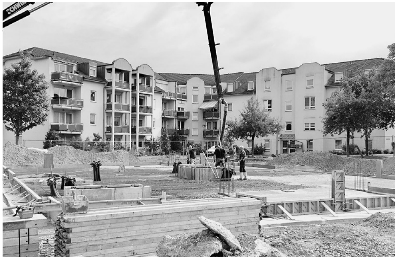
Die erste Bodenplatte wird betoniert.
