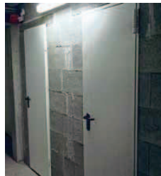
Auch im Kellergeschoss wurde Wert auf hochwertige Baustoffe und Ausführung gelegt so dass auch hier Bisotherm Steine, als Bisobims-Vollsteine zum Einsatz kamen.
