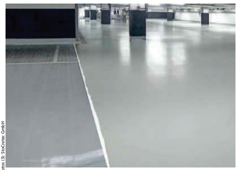
Teilfläche mit fertiggestellter Zwischenbeschichtung. Für die Überarbeitung mit dem finalen Beschichtungssystem war keine zusätzliche Untergrundvorbereitung notwendig.
