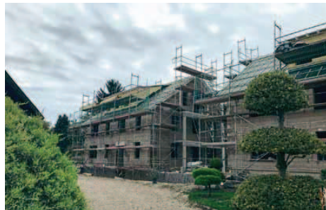
Zwei wertstabile und zukunftsfähige Wohnhäuser gemäß den KfW-55-Vorgaben, gebaut mit Bisotherm auf dem durchgehenden Basisgeschoss aus Stahlbeton.
