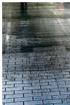
Die Grundierung StoCryl EH 100 wurde auf die Rüttelklinker aufgebracht.
